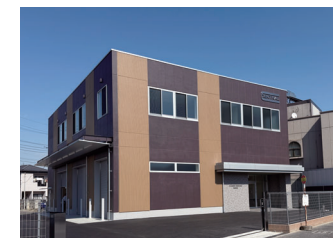
高崎支社(2025年2月竣工)
