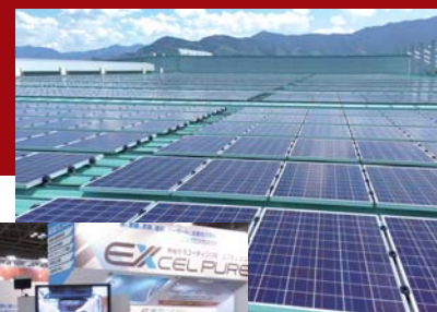
●太陽光パネルへ施工
