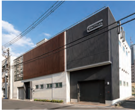
▲研究開発施設「中之島R&Dセンター」。新製品の開発・改良を推進。
