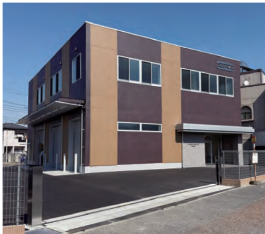
高崎支社(2025年2月竣工)
